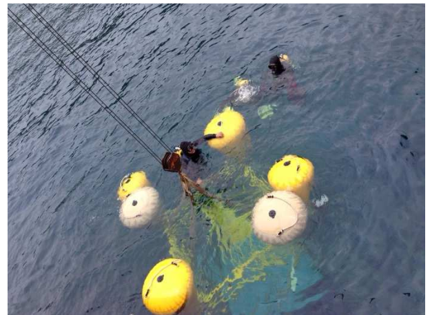
固定部份配合電纜;纜線綁縛壓重固定用水泥塊
