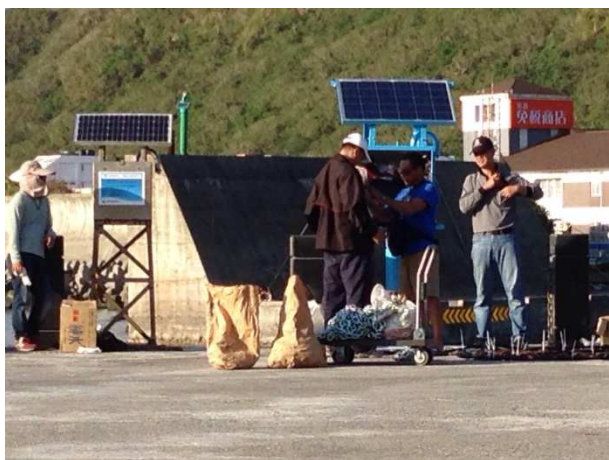
離島佈纜工程
